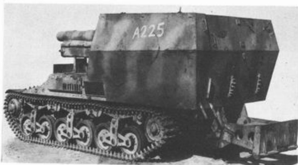
15cm sFH 13 Selbstfahrlafette Lorraine SdKfz 135/1 or 15cm sFH 13 auf GWLrS (f)
